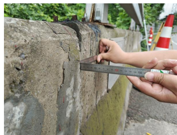
图 3-15 伸缩缝位移量测量
