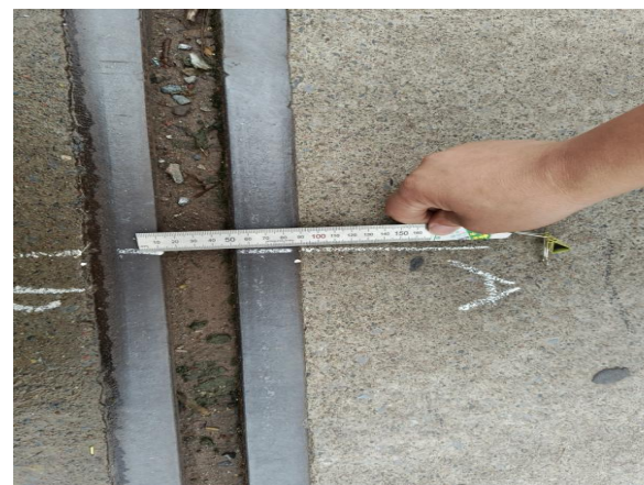
图 3-14 伸缩缝缝宽测量
