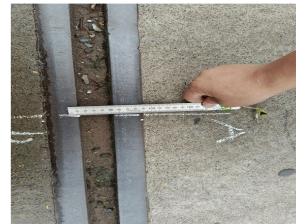
图 3-16 伸缩缝位移量测量
