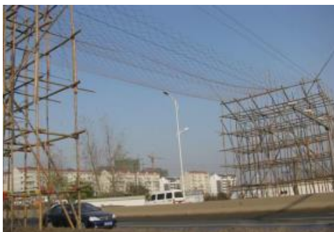
图 3.1-4 线路工程临时跨越方式施工影像示例
