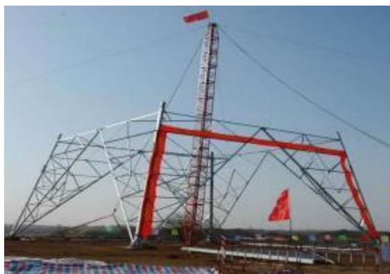
悬浮抱杆组塔
