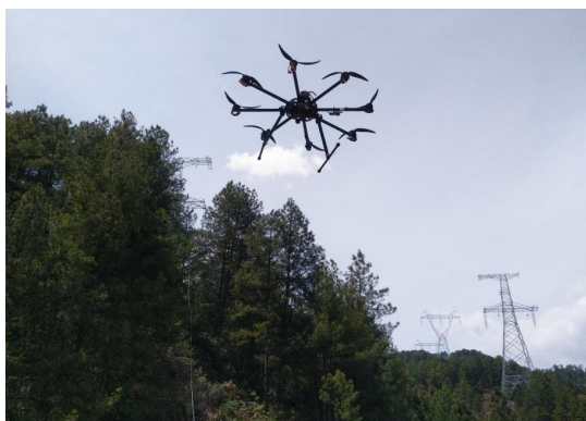
图 3.1-7 无人机放线施工示例
