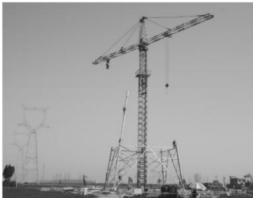
落地抱杆组塔
