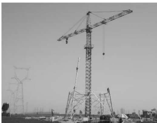
落地抱杆组塔
