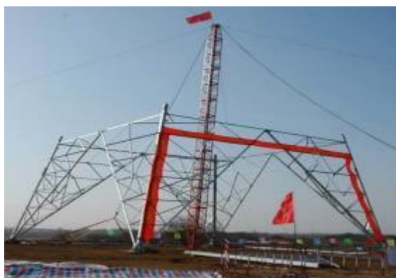
悬浮抱杆组塔
