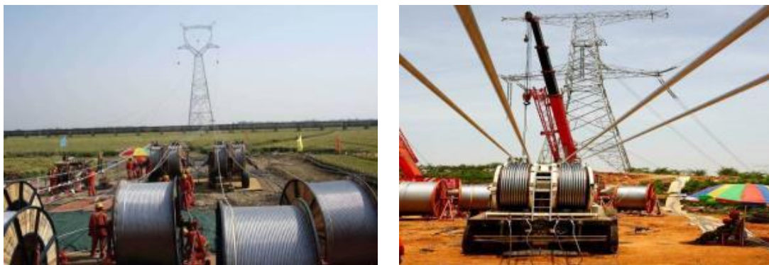
图 3.1-3 线路工程牵张场布置及张放线影像示例
