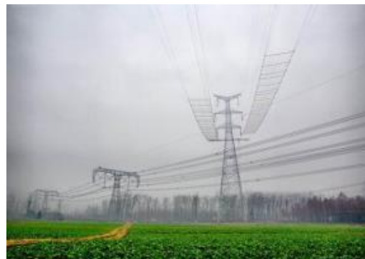
无跨越架（封网）方式示例
