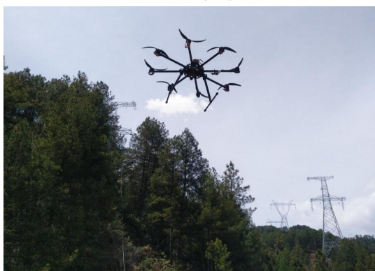
图 3.1-7 无人机放线施工示例
